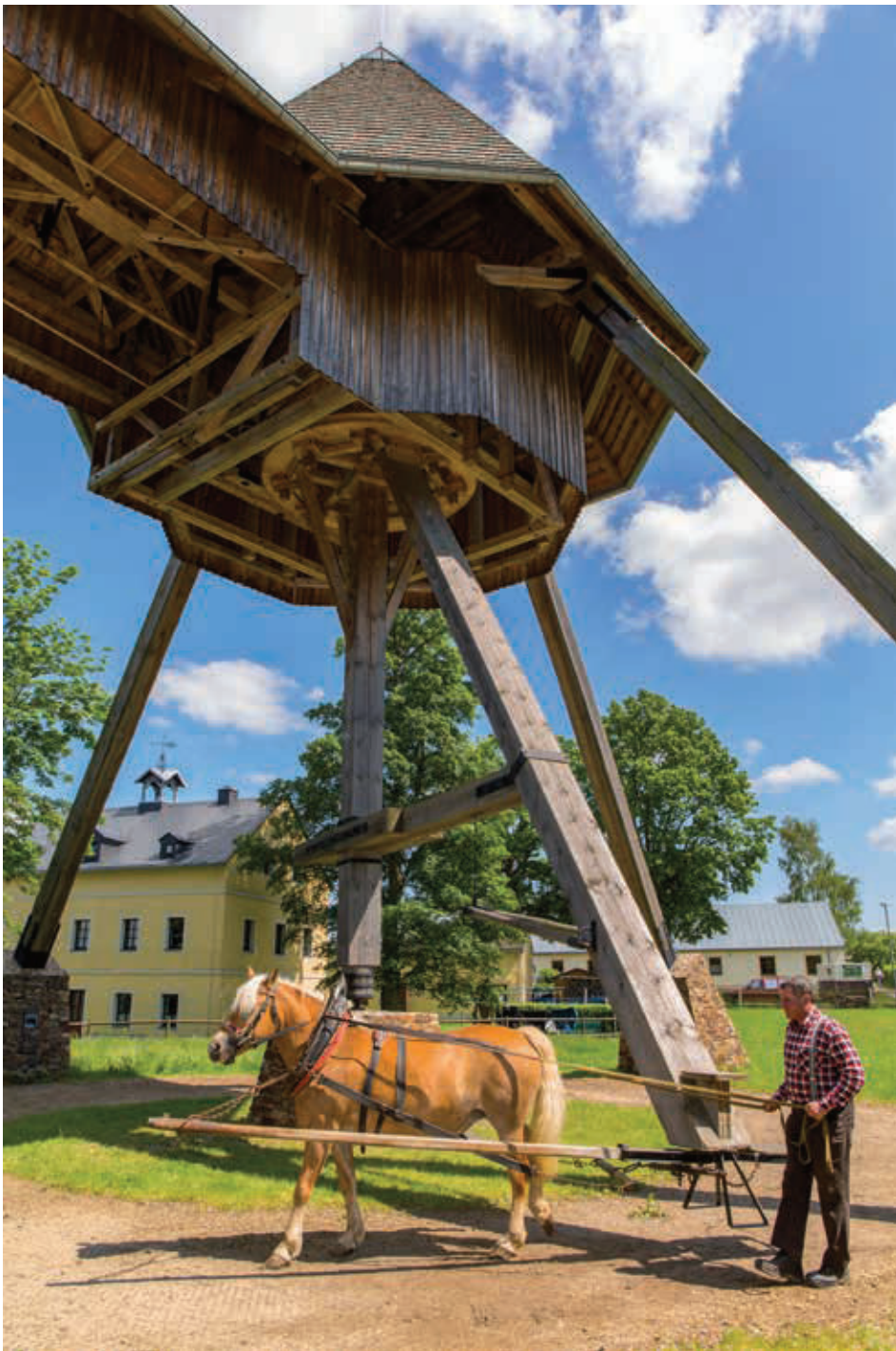
Die 1838 errichtete und 2006 wiedererrichtete Pferdegöpel auf dem Rudolphschacht bei Marienberg. Welterbe Montanregion Erzgebirge e. V.
